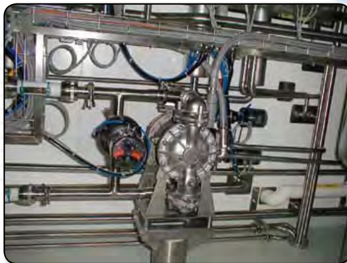
Bomba de válvula de retención de bola con certificación USDA, en una instalación de tubería sanitaria, de limpieza en el lugar.
