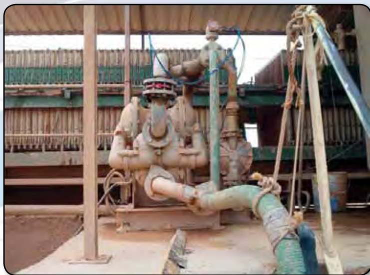
Sistemas de bombeo de presión de filtros para aguas residuales de uso intensivo creados a pedido.
