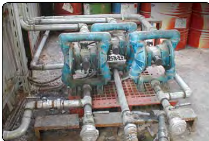
Bombas de uso estándar metálica instaladas por requisitos de bombeo en el sumidero exterior.
