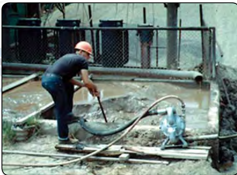
Bomba de válvula de bola de solapa de uso intensivo instalada que bombea la acumulación de sedimentos en estanques. (No es necesaria una alineación perfecta).
