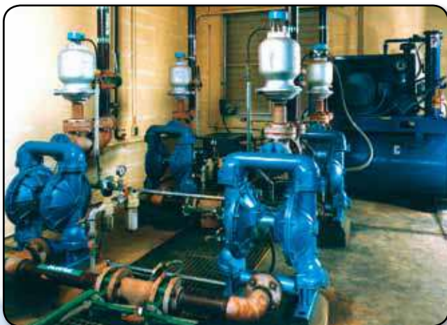
Bombas de uso estándar metálica instaladas de manera permanente en una instalación interior de sumidero en la industria química.
